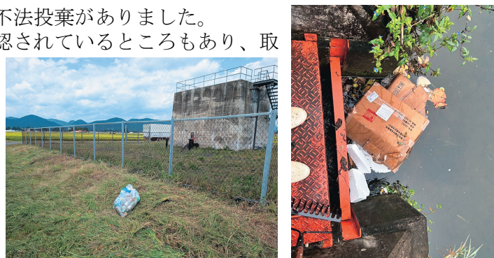
左：狼沢地内配水槽 右：尾花堰頭首工（小瀬川地内）
