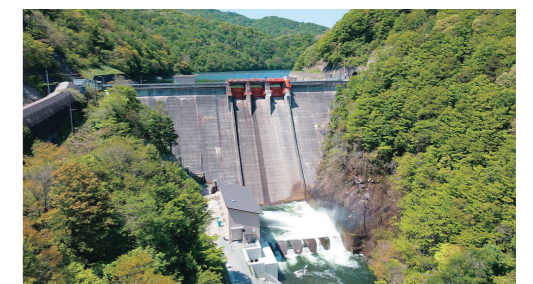
上段: 太陽光発電(宮野目揚水機場) 下段: 豊沢ダム小水力発電所を經由しての放流(中央)
