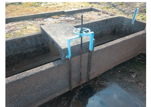
巻岡揚水機場 上段：全景、下段：土砂吐ゲート
