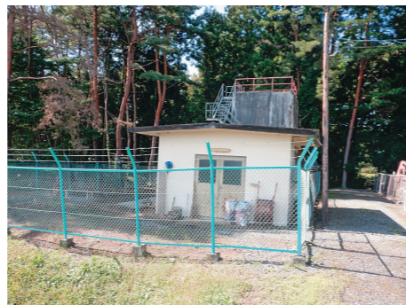
上段：大畑 2 除塵機 下段：北湯口 2 揚水機
