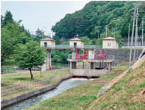
新田堰頭首工
