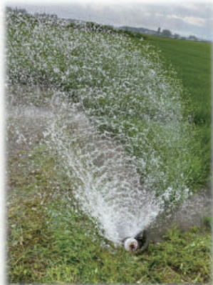
給水栓破損事故
