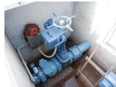
尾花堰揚水機 (水中ポンプ整備 他)
