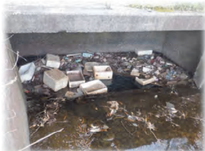
二枚橋地内水路
