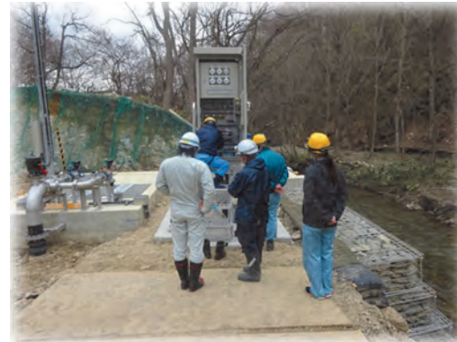
大沢揚水機場試運転
