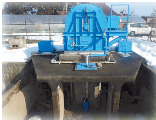
維持管理適正化事業 上根子除塵機補修工事
