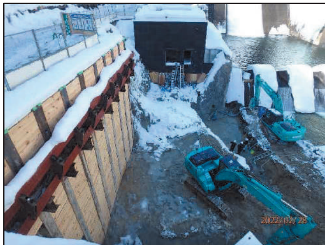
発電所下部工掘削状況 (2月)
