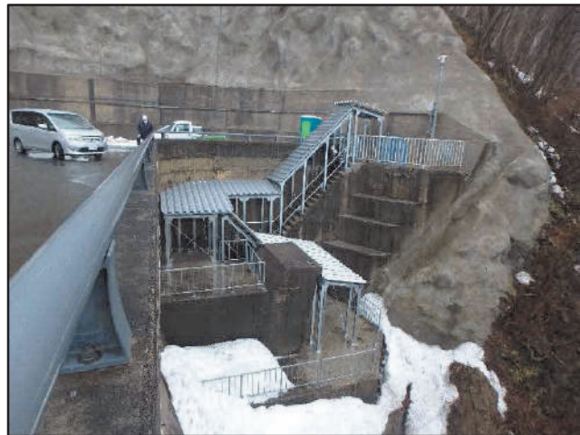
堤体左岸シェルター据付状況 (3月)
