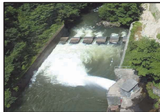
H31 年度主要工事（写真は放流施設の吐き出し口の状況） 吐き出し口に設置されたゲートの更新を 2 ヶ年で実施予定
