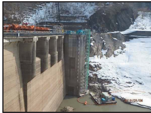
H31 年度主要工事（写真は放流施設の吐き出し口の状況） 吐き出し口に設置されたゲートの更新を 2 ヶ年で実施予定
