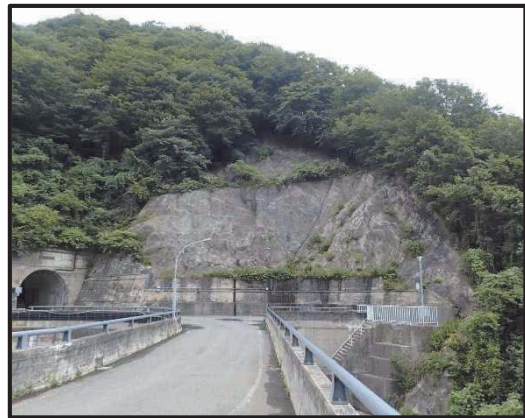
H30 年度工事（堤体左岸法面工事） 上写真：着工前 下写真：完成
