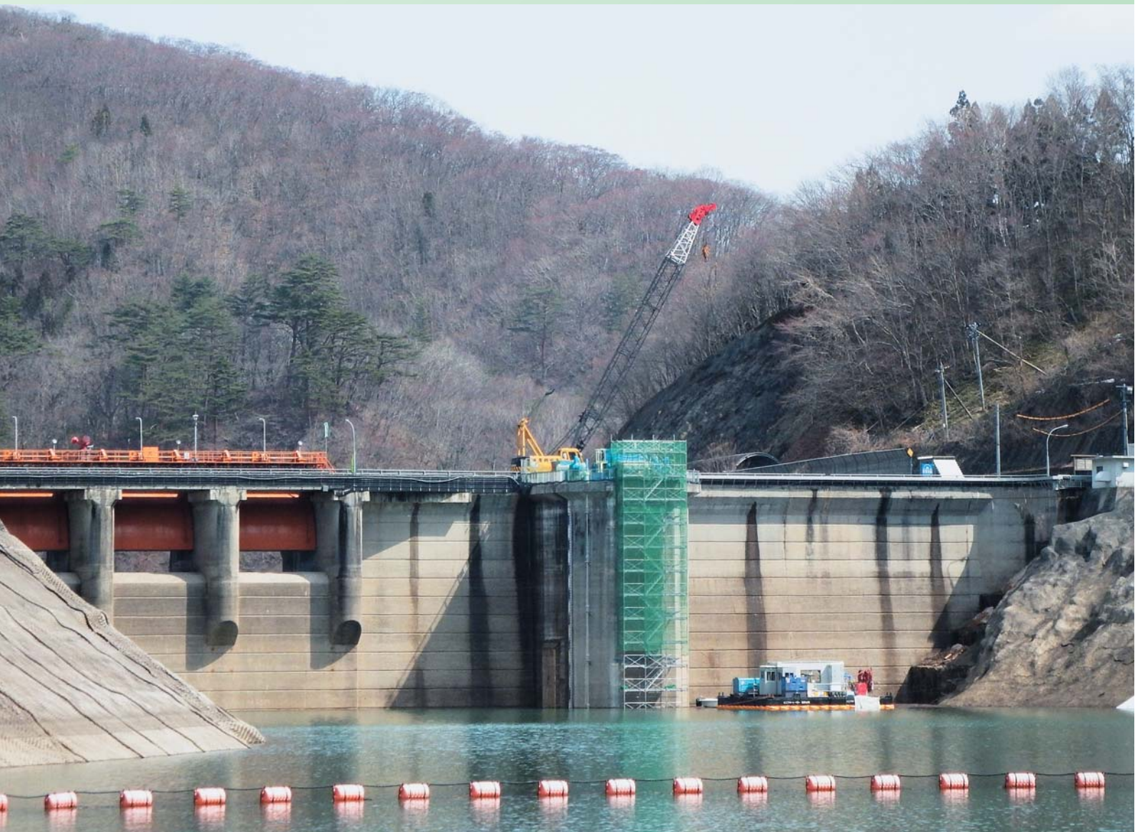
改修工事が進む豊沢ダム（豊沢湖側から）
